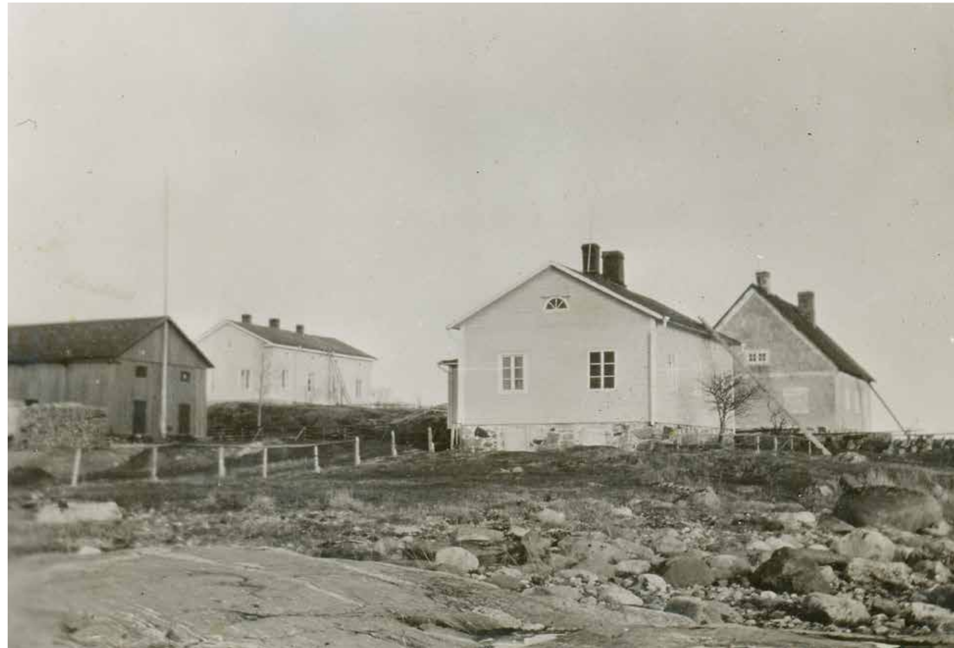
Ajoittamaton kuva Fagerholman rakennuksista. Ylhäällä Humina ja etualalla vanha asemarakennus, kumpikin on sittemmin purettu. FORUM MARINUM, UNO OJASEN KOKOELMA
