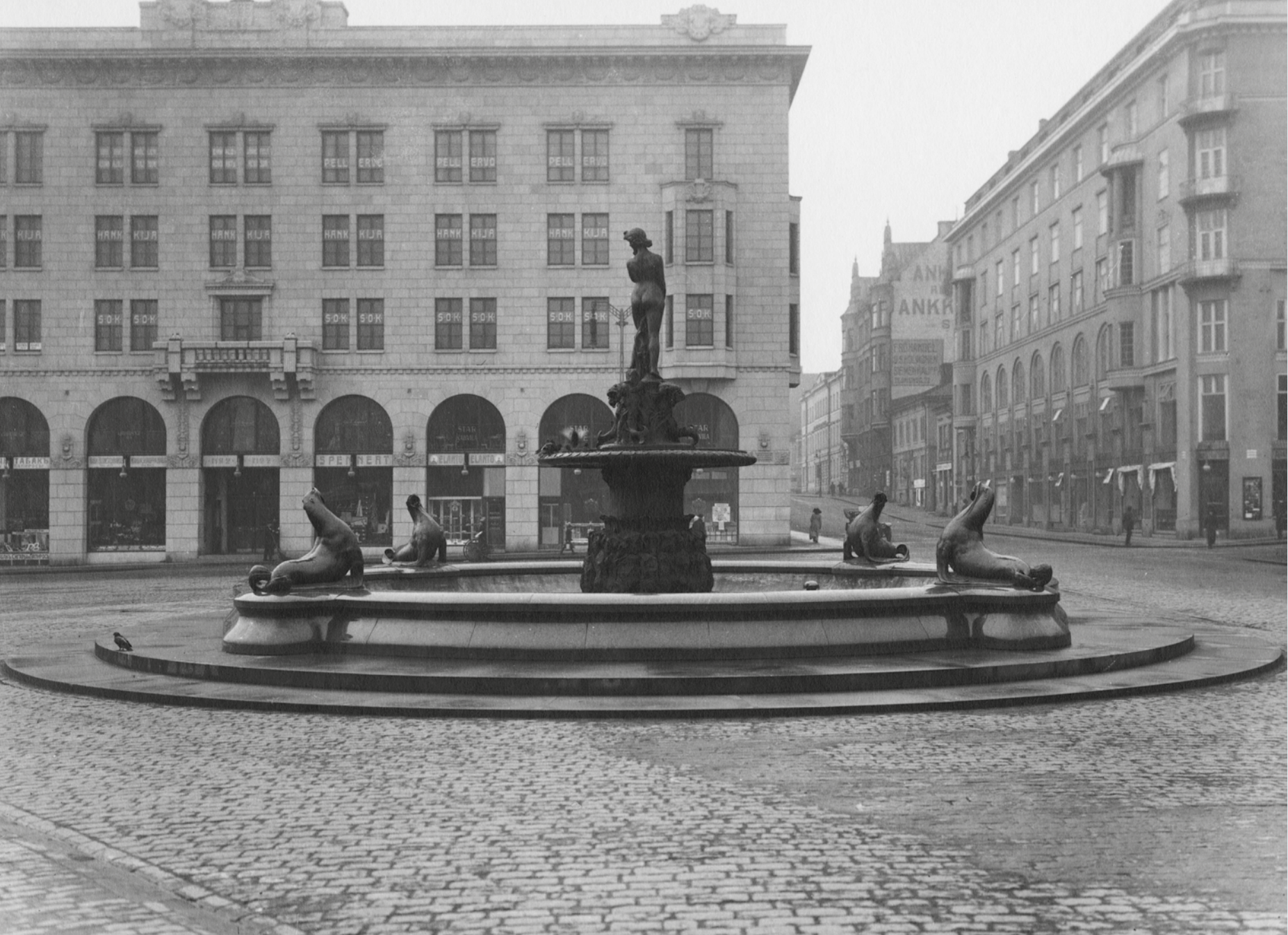
Kuvassa Valtiontalon Unioninkadun puoleinen julkisivu kadun oikealla puolella. Merivartiolaitoksen esikunta aloitti toimintansa siellä 1.6.1930. HELSINGIN KAUPUNGINMUSEO
