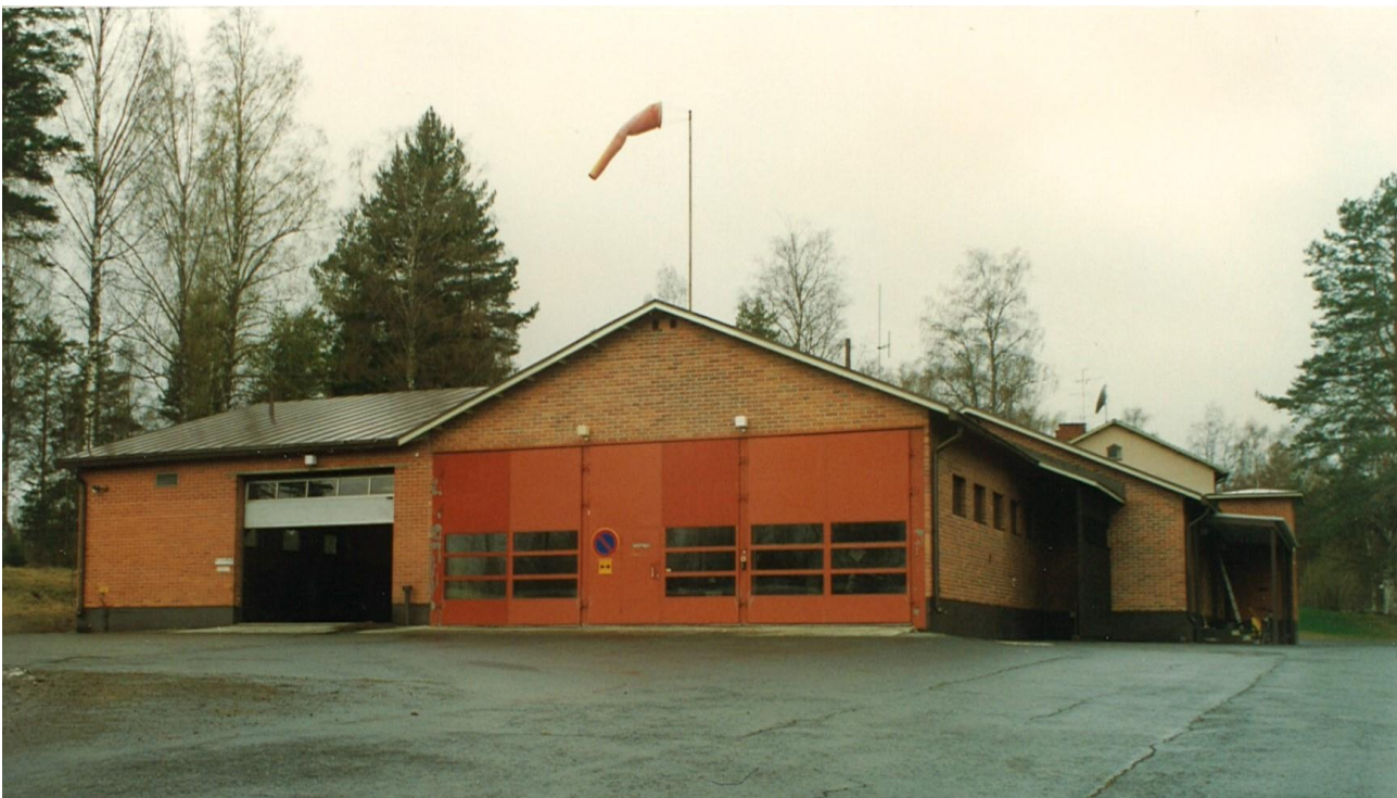
Tohmajärven johtopaikan autotalli ja huoltorakennus Kirkkoniemessä.
